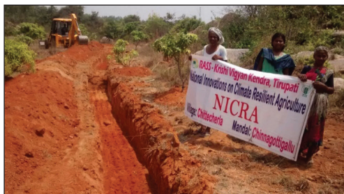
Trench cum bunding in mango
